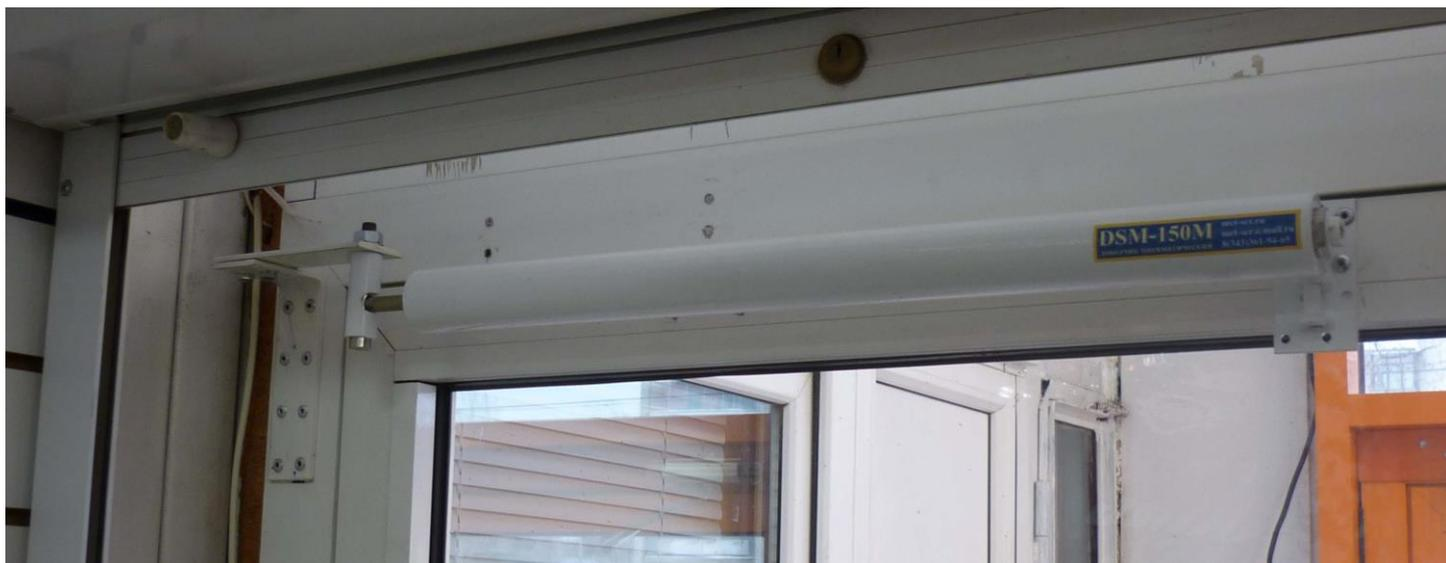
и настраиваем скорость закрывания при помощи крана Маевского:
